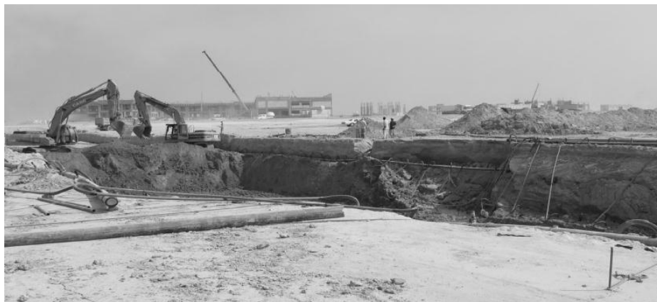
Figura 47. Procedimiento de mejoramiento del suelo en el área residencial a 20 Km de la ciudad de Kuwait.
