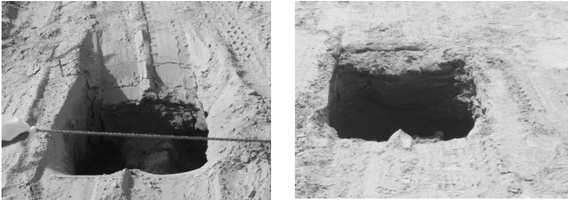
Figura 46. Imágenes de dos colapsos en la superficie producto de cavidades subterráneas (aproximadamente 1,03 m X 1,15 m de diámetro cada respectivamente).
