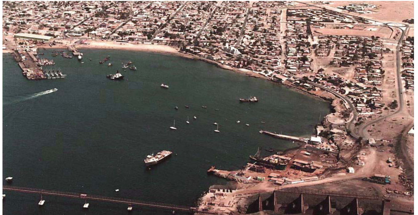
Fig. 1: Vista aérea de Caldera y el Muelle Mecanizado a intervenir. Fuente:chrysalis.cl
