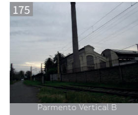
Paramento Vertical B
