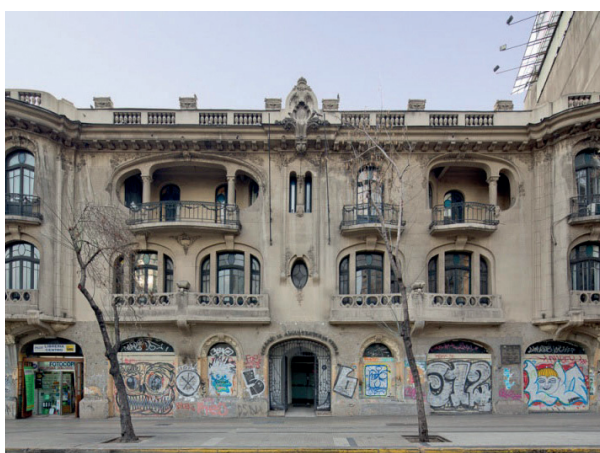
Figura 50. Obras representativas del cuarto periodo de declaración. Fuente imagen casa de Frei Montalva: Blogspot "Fauna Política". Fuente imagen Iglesia del Tránsito de la Santísima Virgen Maria: Wikimedia Commons. Fuente imagen Bodega Norte Maestranza San Eugenio: CMN. Fuente imagen Casa del ex Fundo El Manzano: Wikimedia Commons. Fuente imagen Sede Nacional del Colegio de Arquitectos: Plataforma Urbana.
