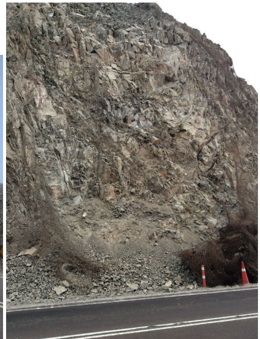
(b) Talud actual en Pabellón de Pica, 2014
