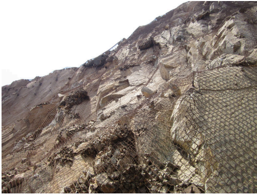
(a) Malla talud Este, Punta Guanillos
