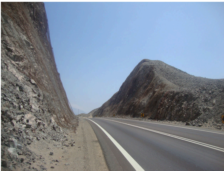
(a) Pabellón de Pica, 2014
