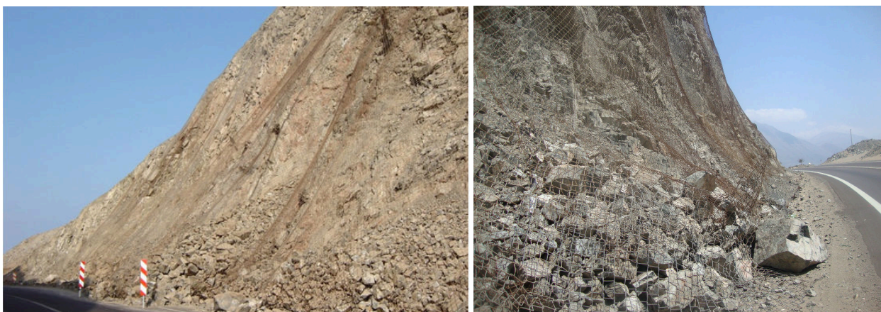
(a) Pabellón de Pica, 2007
