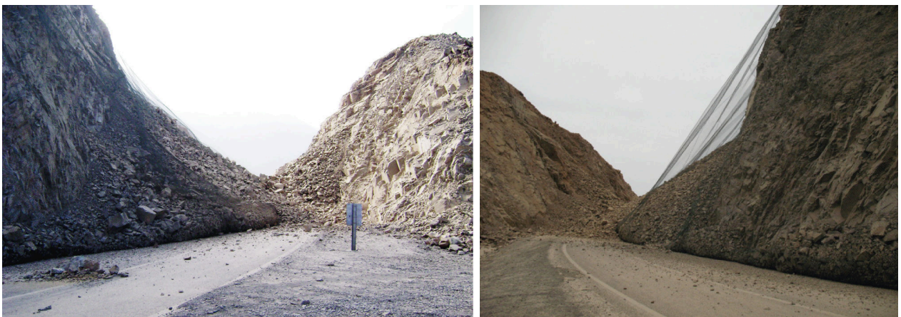
Figura 5.9: Punta Paragua post terremoto Tocopilla 2007, se observa como fue cargada por completo la malla de contención. Gentileza MOP.
