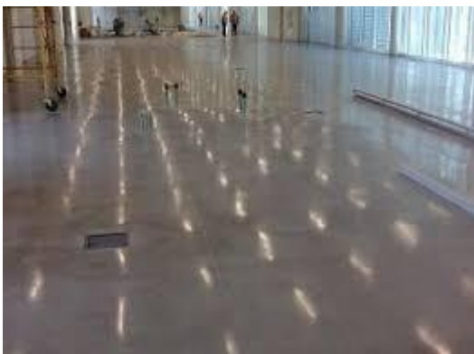
Revestimiento pisos interiores Sikafloor 20N PurCem
