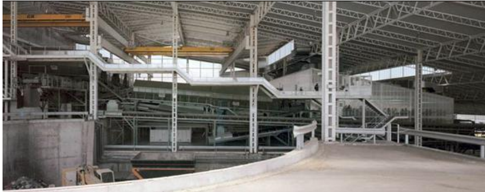
Figura 10: Interior de Planta Valdemingómez
