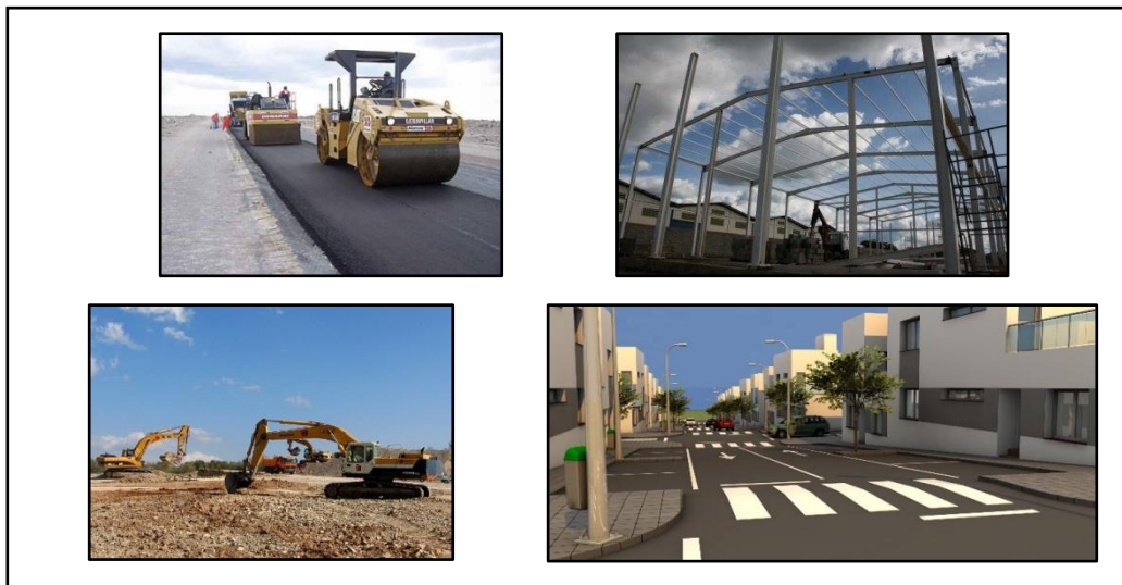
Figura N°4: Obras de construcción CHCR Construcción S.A. (Fuente: Propia)
