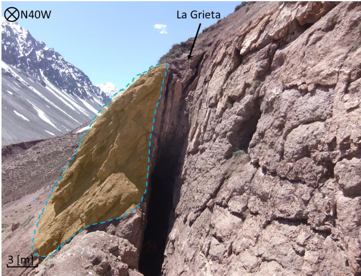
Figura 5.1.2.7: La Grieta y depósitos de remoción cementados con carbonatos sobre los travertinos.
