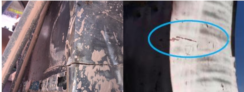
Ilustración 21. Fisuras en mango.
