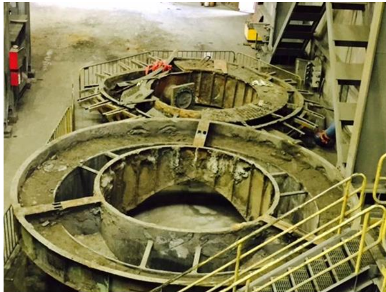
Ilustración 26: Cajones underflow y overflow que se debe retirar del área de trabajo. Fuente: Fotografías de elaboración propia en CMDIC, 2016.
