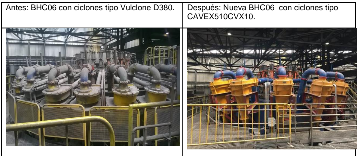
Ilustración 30: Antes y después del upgrade de la BHC06. Fuente: Fotografías de elaboración propia en CMDIC, 2016.
