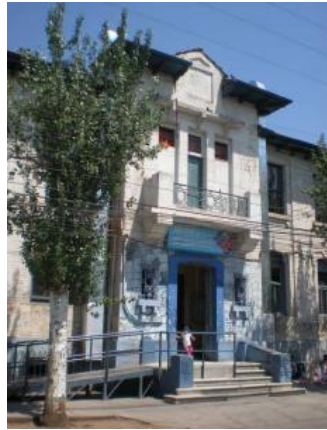
Ilustración 3. Hospital Exequiel González Cortés
