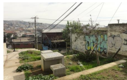
Miradores en mal estado.
