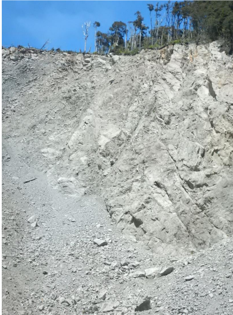
Figura 25.- Fotografía de la ladera SE del deslizamiento de Punta Cola, la cual permite evaluar de mejor manera el GSI del macizo.
