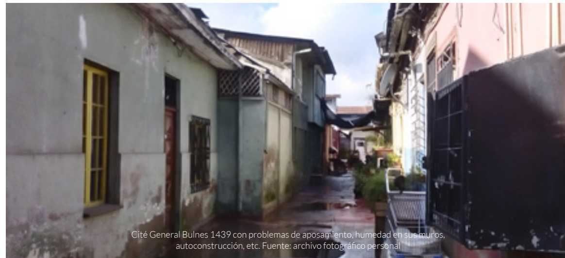
Cité Cautín 962 con serios problemas de pavimento debido al deterioro del alcantarillado. Fuente: archivo fotográfico personal
