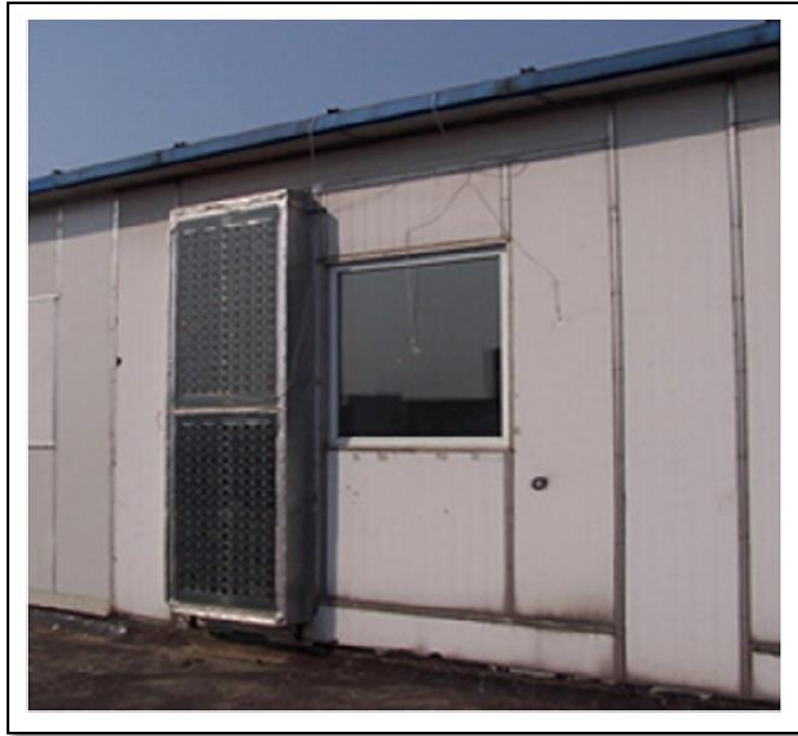
Figura 1.5: Muro Trombe con panel fotovoltaico [8].
