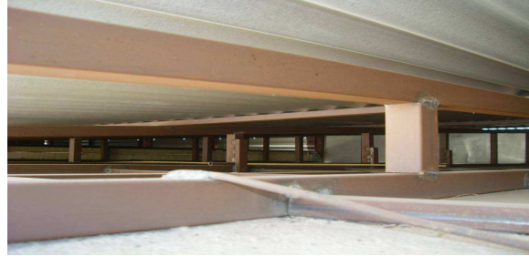
Figura 22. Entretecho de una vivienda en construcción.
