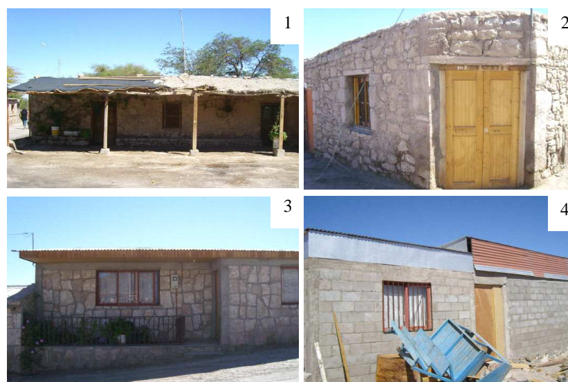
Figura 13. Modalidad de construcción en Peine. (1) y (2) corresponden a viviendas de tipo tradicional, mientras que (3) y (4) a viviendas industrializadas
