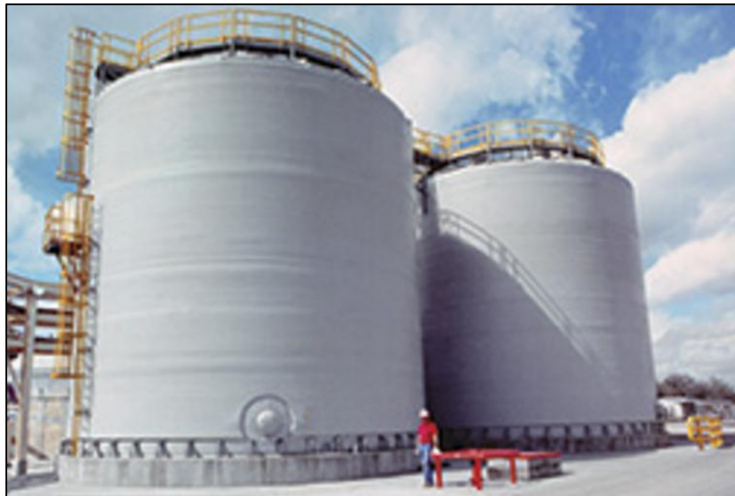
Figura N° 3.1: Estanques de PRFV [1]
