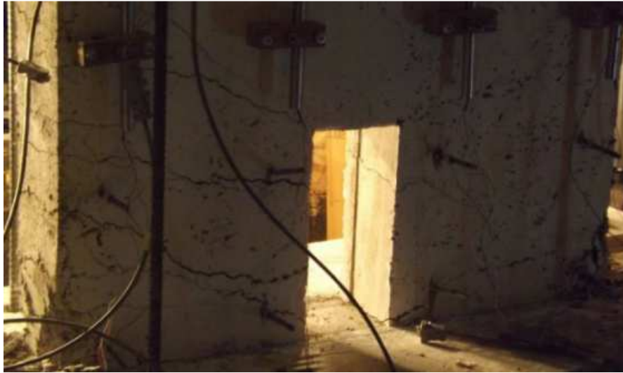
FIGURA 5.5 PATRÓN DE GRIETAS (IZQUIERDA) Y PANDEO FUERA DEL PLANO (DERECHA).
