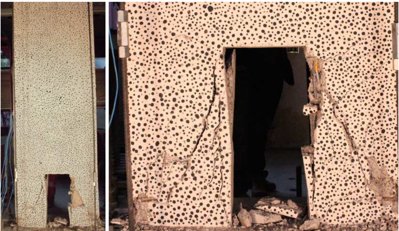
FIGURA 5.20: ESTADO FINAL MURO MR3 (IZQUIERDA). GRIETAS DE CORTE GENERADAS EN LAS PATAS DEL MURO (DERECHA).
