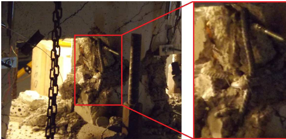
FIGURA 5.14: PANDEO DE LA BARRA DE REFUERZO DE ABERTURA AL FIN DEL ENSAYO.
