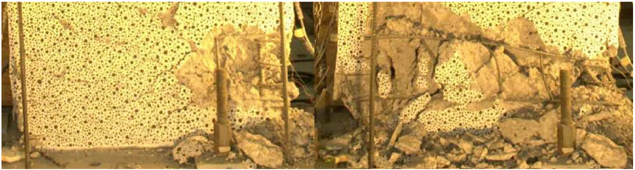
FIGURA 5.31: AUSENCIA DE GRIETAS DE CORTE, MRO
