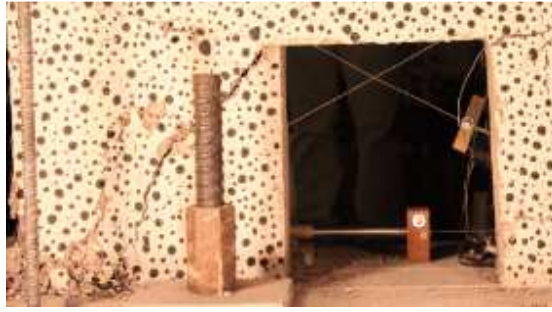
FIGURA 5.13: GRIETA DE CORTE QUE GENERÓ LA PÉRDIDA DE CAPACIDAD.
