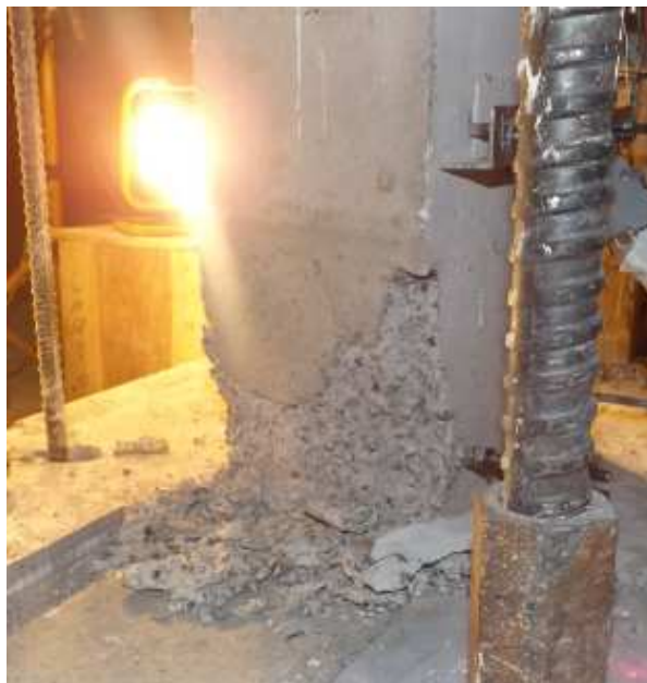
FIGURA 5.12: DESPRENDIMIENTO DE HORMIGÓN EN ELEMENTO DE BORDE.
