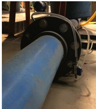
Figura 3.4: Placa orificio.
