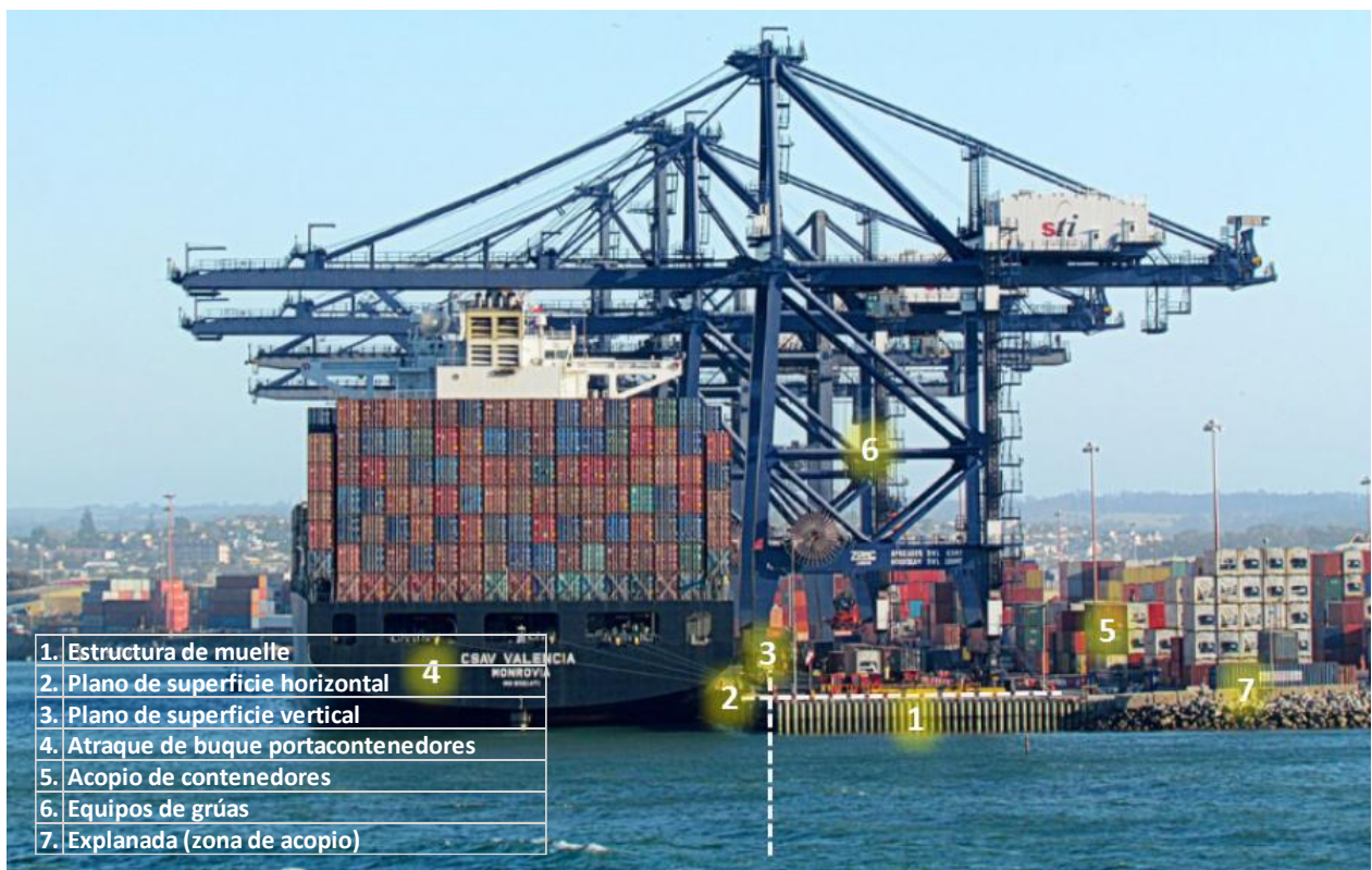
Figura 2.2: Estructura de muelle y sus principales elementos.
