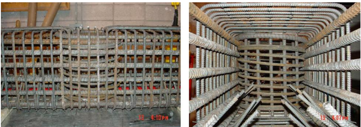
Figura 2.8: Conexión tipo Embedded Pile sin hormigonar.
