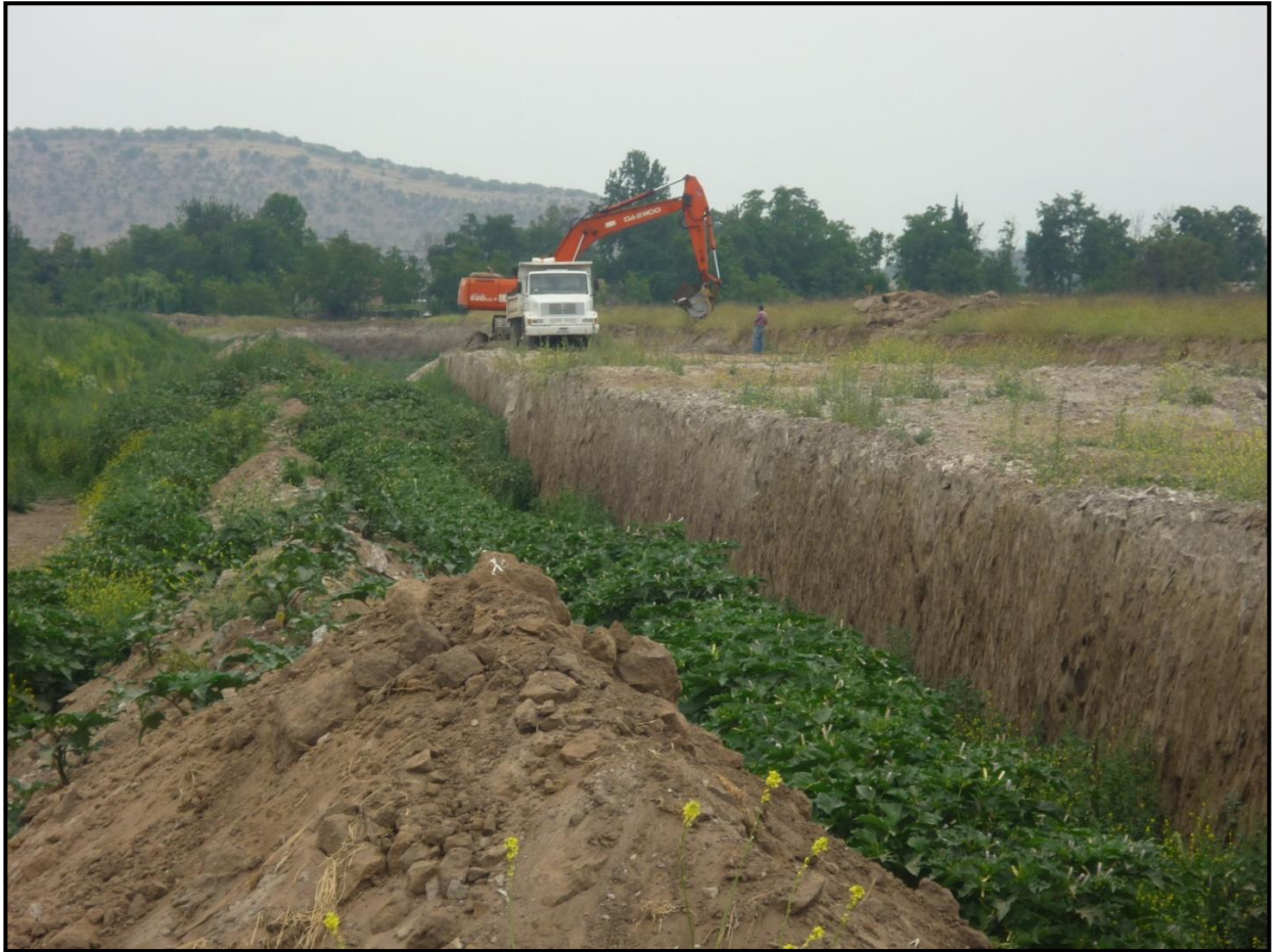
Foto 2: Maquinaria pesada cargando camión en potrero El Quillay.
