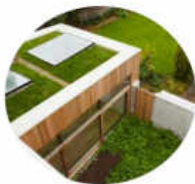
Cubiertas verdes transitables con claraboyas.
