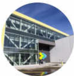
Estructura para los bloques de trabajo e investigación. Entramado de perfil H.
