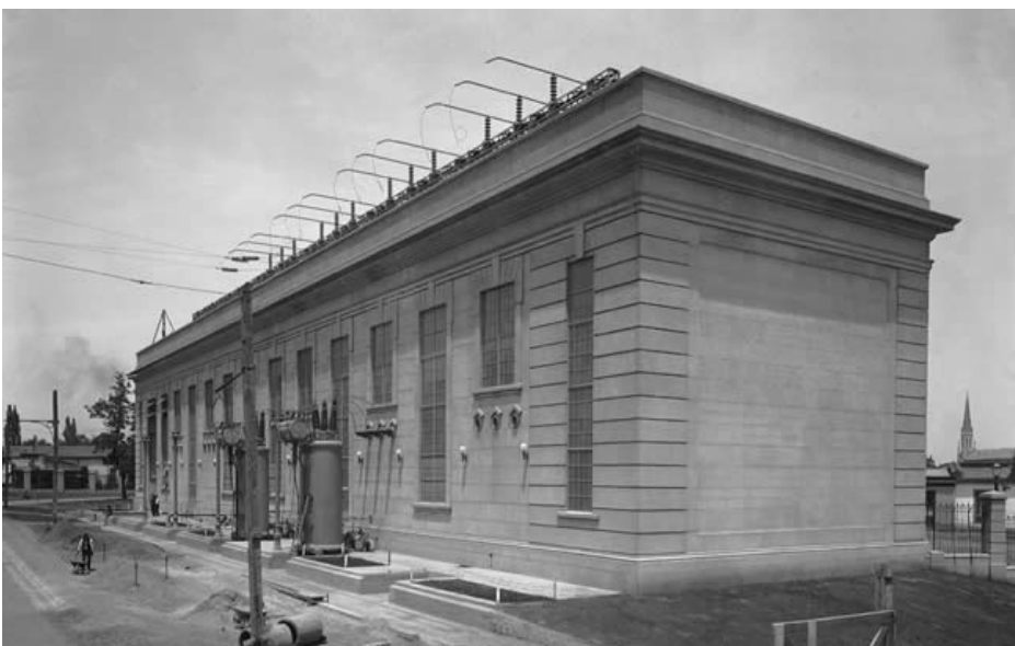
Fig 29. Subestación eléctrica San Cristóbal, 1922
