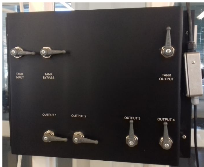
(a) Panel controlador de circulación de agua desaireada
