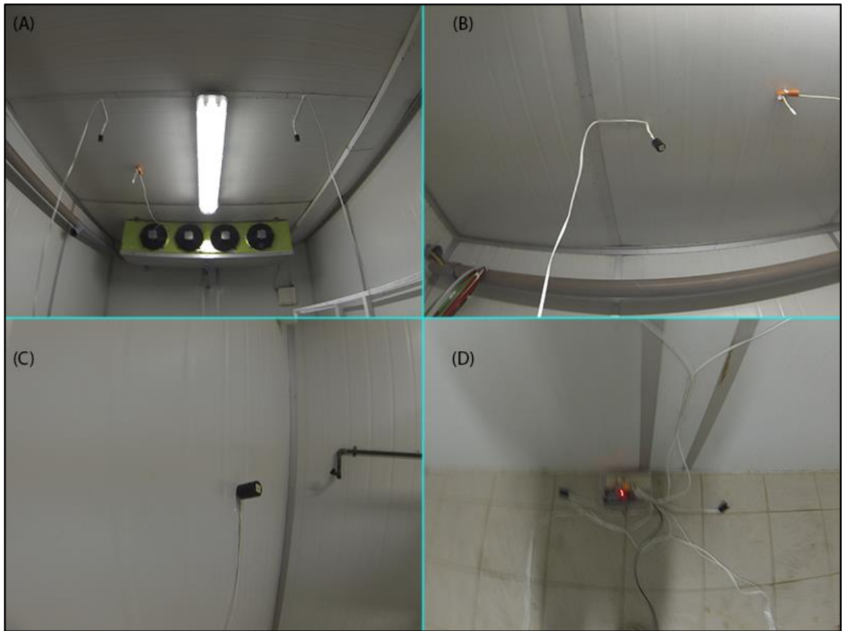
Figura 6. Instalación de sensores DS18B20 y sistemas Arduino al interior de la cámara de frío. (A) Sensores ubicados a la salida del evaporador. (B) Sensor low-cost (izquierda) y sensor del sistema de enfriamiento de la cámara fría (derecha). (C) Sensor low-cost en la zona de retorno del evaporador. (D) Placa Arduino y cableado del sistema creado.
