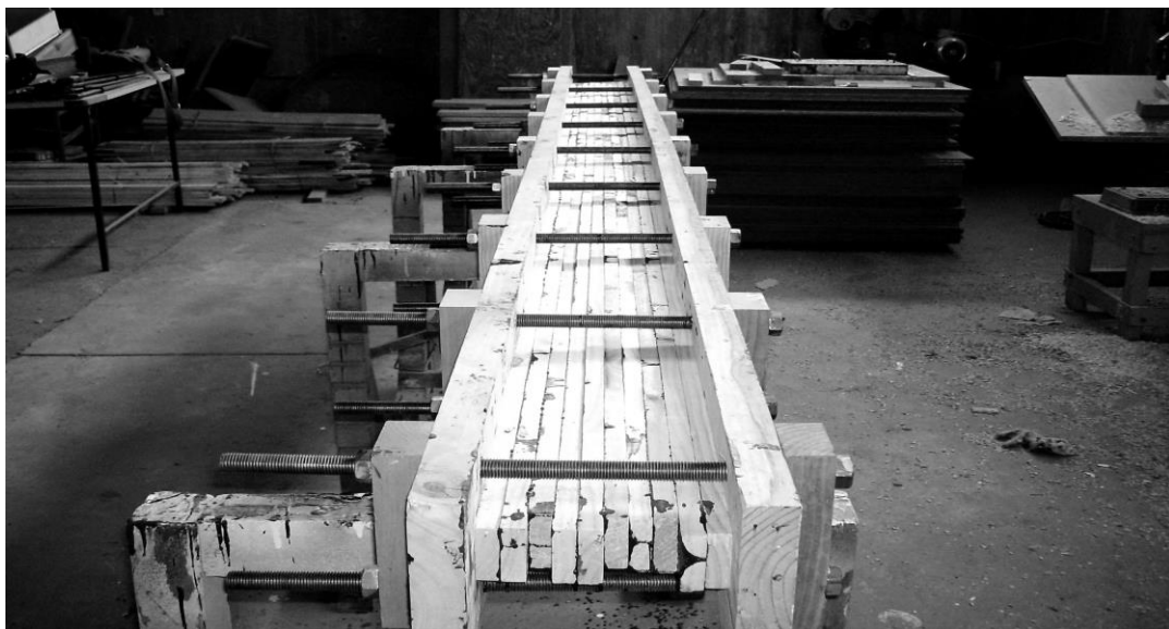
Figura 4: Disposición de una viga de madera laminada encolada en la línea de prensado
