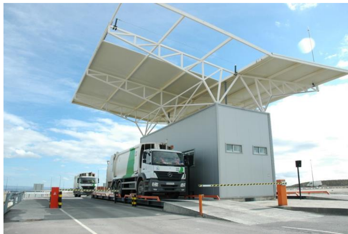
Figura 8: Área de recepción, control y pesaje
