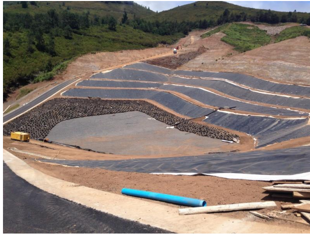
Figura 2: Impermeabilización basal. Fuente: https://www.maccaferri.com/es/
