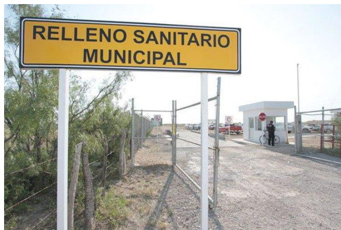
Figura 6: Acceso relleno sanitario.
