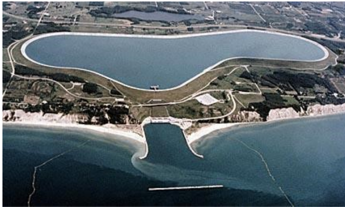
Figura 2.8: Central de bombeo en Ludington, Michigan
