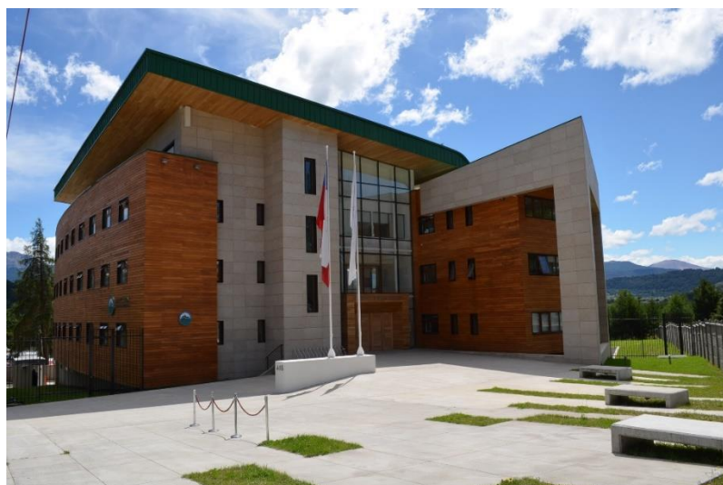
Figura 34. Edificio del Gobierno Regional de Aysén.
