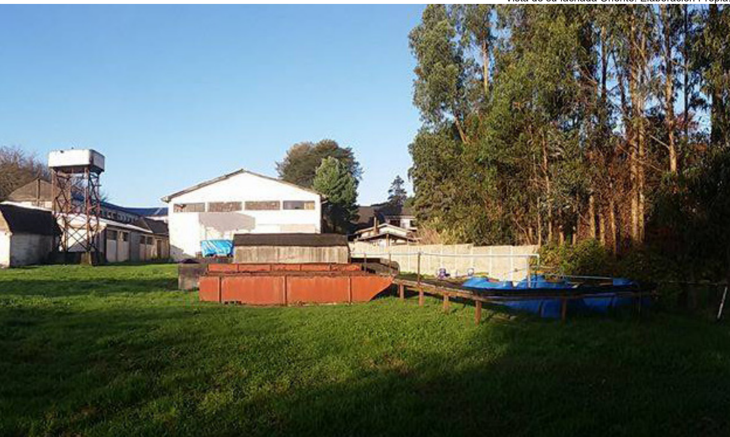
Curtiduría Stolzenbach desde límite con el río Calle Calle. Vista de su fachada Poniente. Elaboración Propia.
