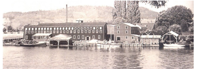
Instalaciones demolidas de la Curtiduría Stolzenbach. Fotografía año 1920.
