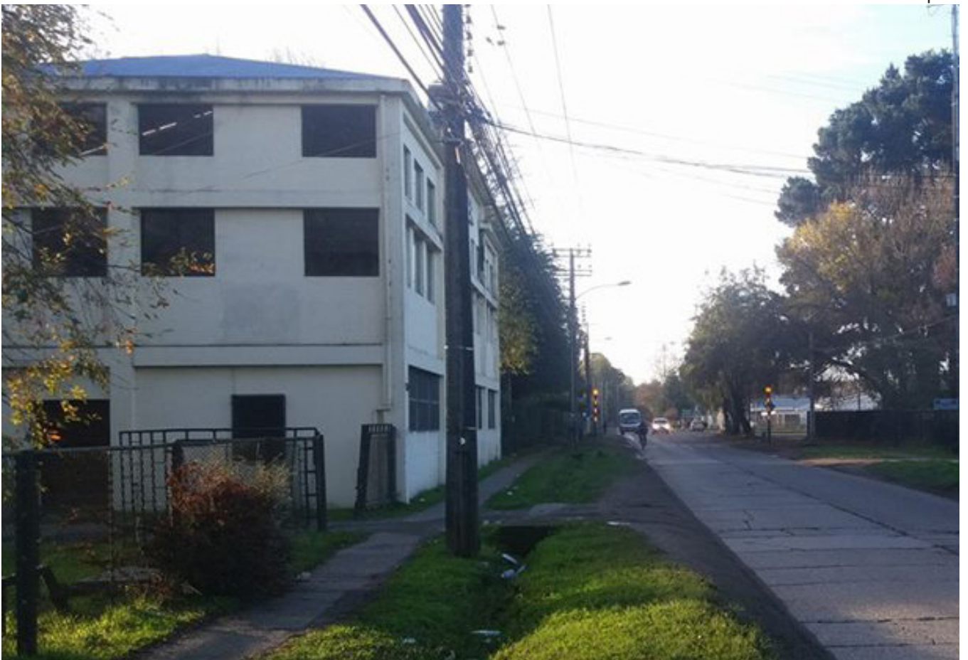
Curtiduría Stolzenbach desde Avenida Balmaceda. Elaboración Propia.
