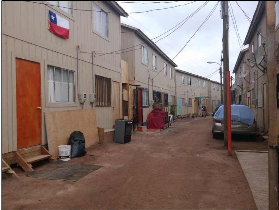
Figura N° 49: Vista, Barrio de emergencia Mirador, ubicado en zona expuesta a amenaza de deslizamiento. Imagen tomada en terreno.
