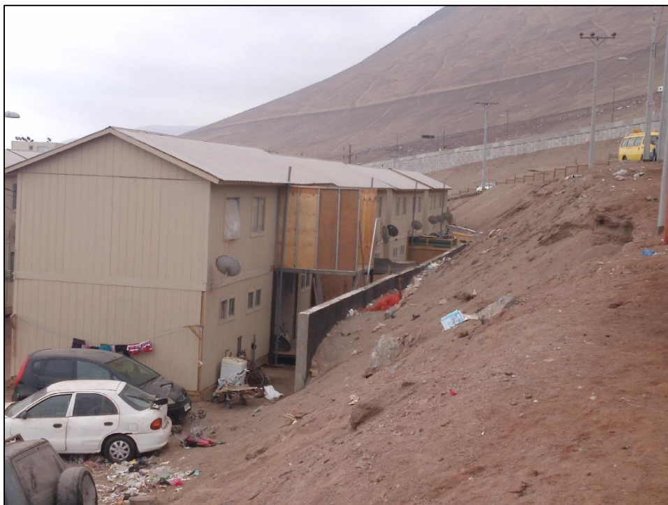
Figura N° 50: Barrio de emergencia Mirador, muros de contención para deslizamientos de material. Imagen tomada en terreno
