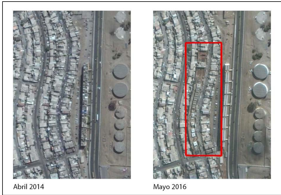
Figura Nº 14: Población Mauque, sector de viviendas demolidas al año 2016 (20°14'11,42''S – 70°07'43,72''O). Fuente: Fuente: Google Earth
