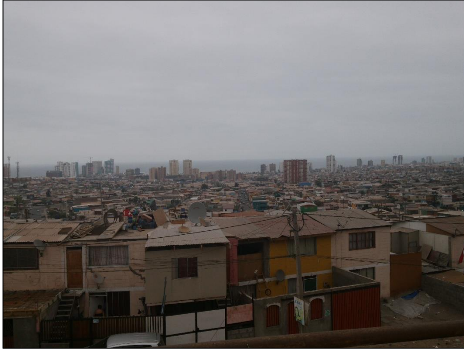
Figura Nº 53: Precariedad material de viviendas y autoconstrucción de ampliaciones, Distrito censal La Tirana. Imágenes tomadas en terreno
