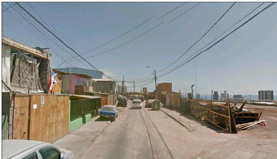
Figura N° 24: Población Mauque, estado de demolición de las viviendas año 2015. Fuente: Imágenes Google Earth 2016
