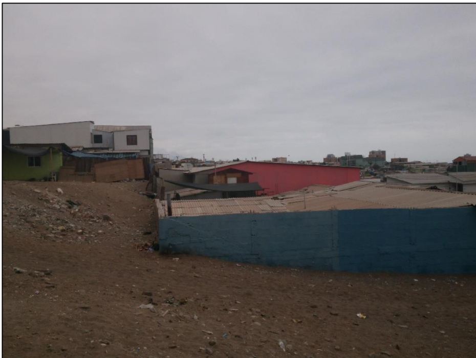
Figura Nº 54: Viviendas afectadas por el deslizamiento de material arenoso, complejo duranio Cerro Dragón. Imagen tomada en terreno
