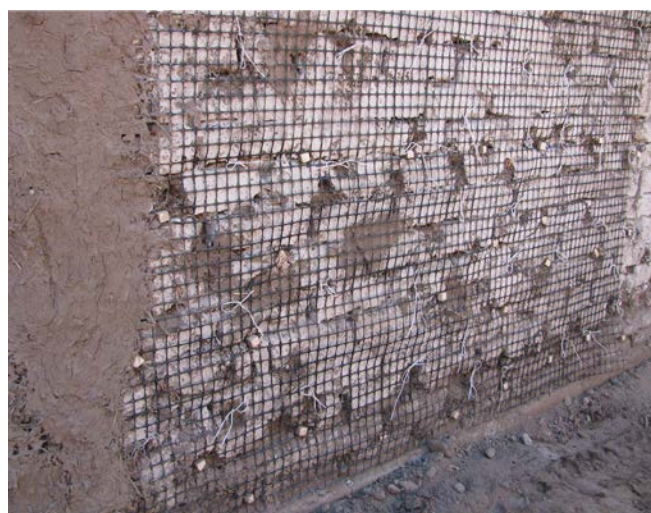
Figura 6. Refuerzo de muros de adobe con geomalla en recuperación de monumentos. Fuente: Claudia Torres.
