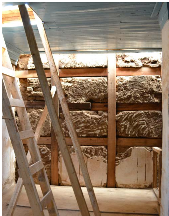
Figura 7. Sistema de consolidación de muros de adobe con exoesqueleto de madera. Fuente: Soledad Valdívia.
