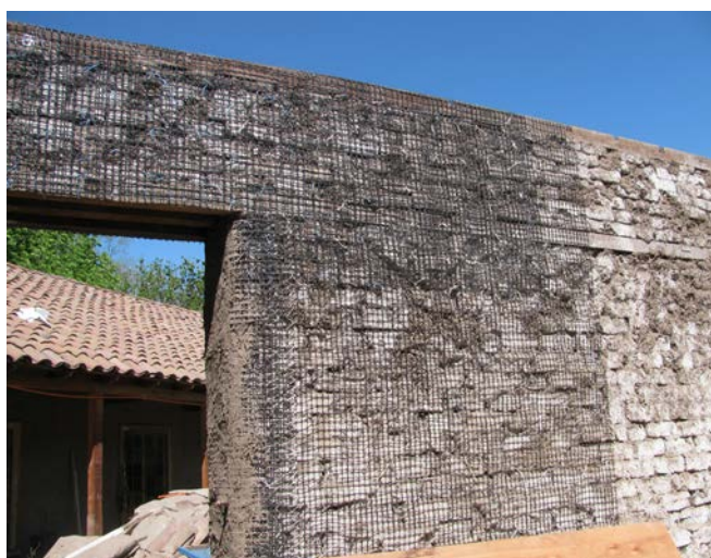
Figura 6. Refuerzo de muros de adobe con geomalla en recuperación de monumentos. Fuente: Claudia Torres.
