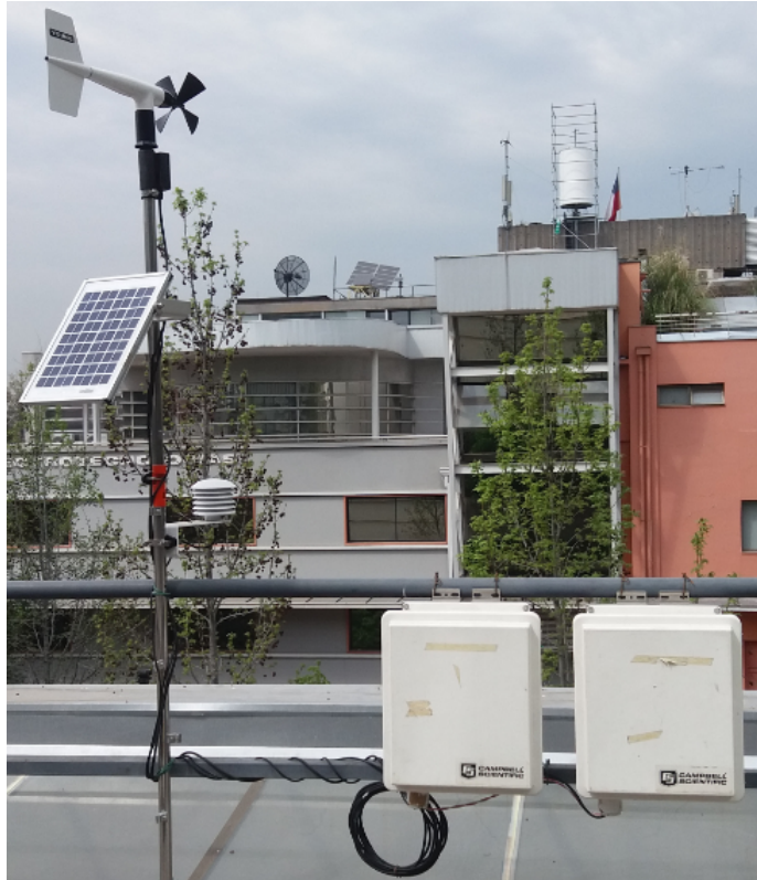
Figura 3.5: Estación meteorológica. Mide humedad relativa, temperatura del aire y velocidad del viento.
