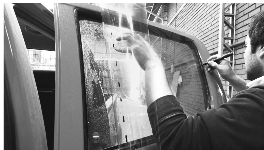
Fotografía de instalación de láminas de seguridad.
