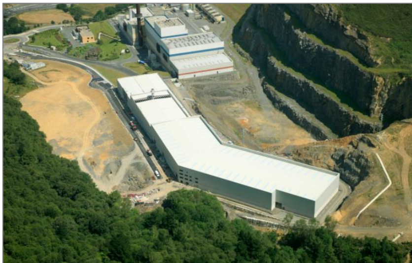
Figura 7. Vista aérea de la TMB de Bilbao. Fuente: http://garbiker.bizkaia.eus/Esp/ca_Pag_438.htm
