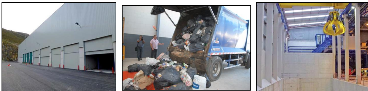
Figura 21. Puertas de entrada de camiones con RSU al área de almacenamiento temporal, descarga de camión recolector y área de almacenamiento temporal de residuos
