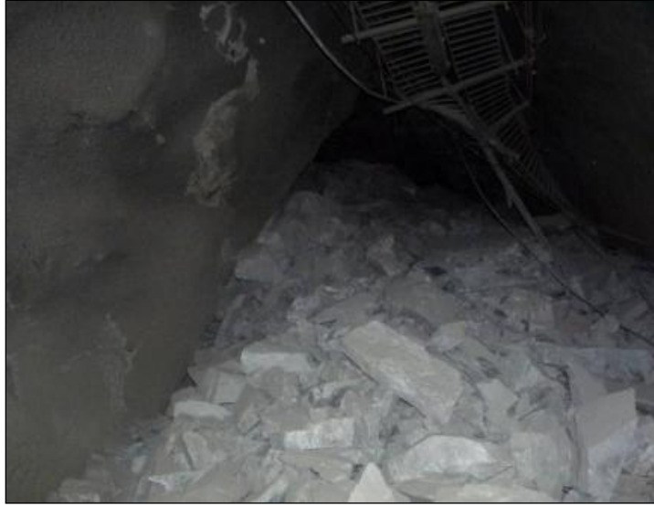
Figura 1 Daño en infraestructura (galería de sección de 6.0x6.0 m) debido a sismicidad inducida (estallido de roca)
