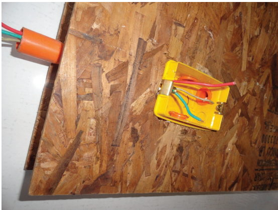
Figura 7e Instalación eléctrica
