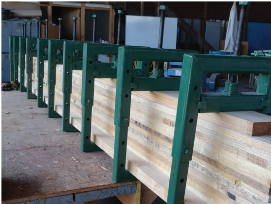
Figura 8c Preparación de Vigas laminadas
