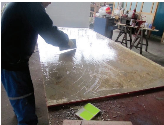
Figura 7a Encolado de paneles OSB
