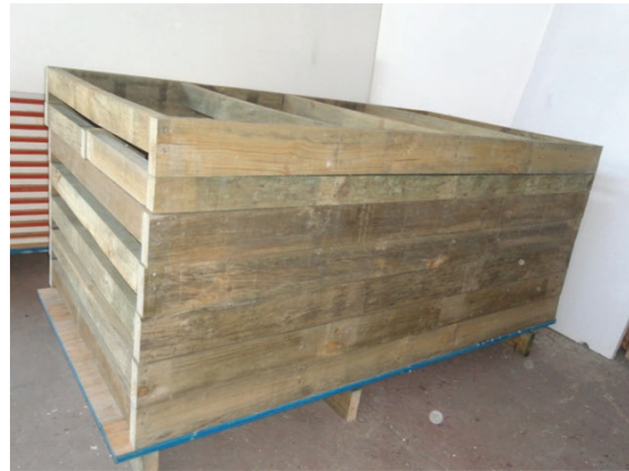
Figura 8d Preparación Entramados de piso
