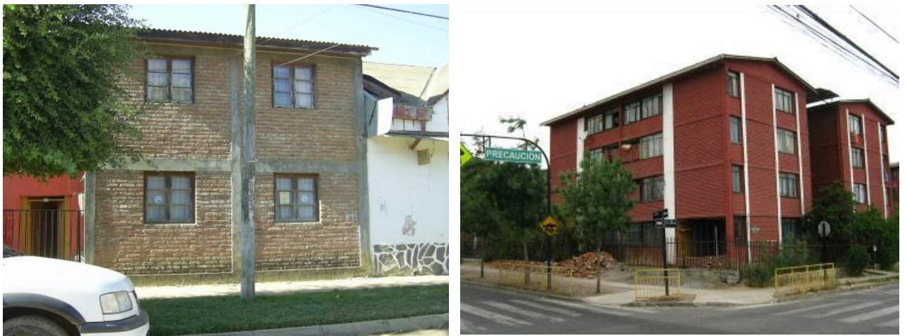
Figura N° 6. Estructuras típicas de albañilería confinada chilena (Castro, 2011).
