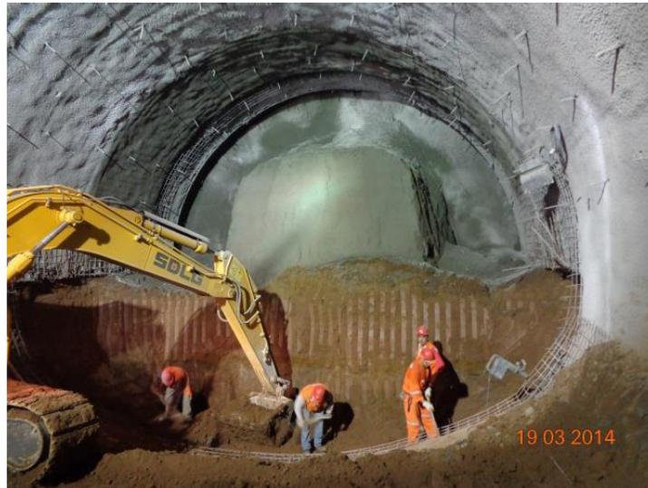
Figura 3-5: Secuencia constructiva, fase II, paso 14, (Pozo, J., 2015)
