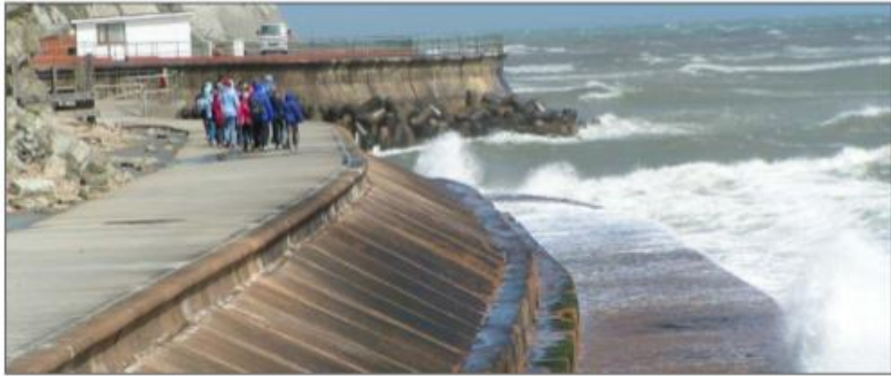
FIGURA 7. MURO COSTERO EN TALUD (FUENTE: DOP, 2013).
