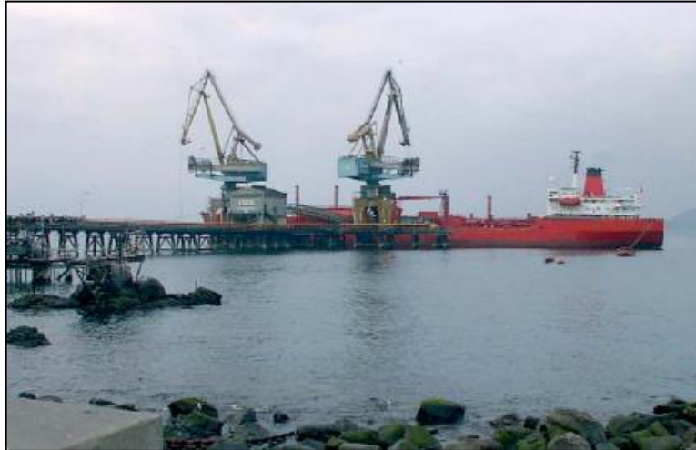
FIGURA 12. MUELLE DE PENETRACIÓN. PUERTO TOCOPILLA ELECTROANDINA. (FUENTE: DOP, 2005)
