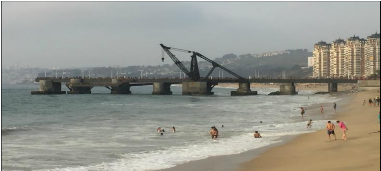
FIGURA 10. MUELLE VERGARA, VIÑA DEL MAR. EJEMPLO DE MUELLE TRANSPARENTE (FUENTE: ARCHIVOS PROPIOS).
