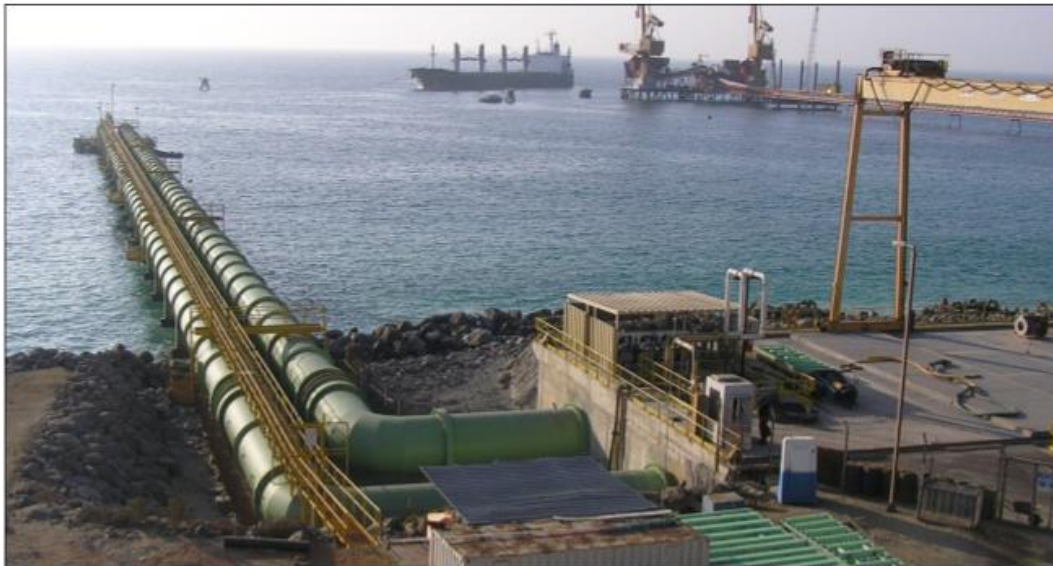
FIGURA 16. DUCTO DE ADUCCIÓN (FUENTE: DOP, 2013).
