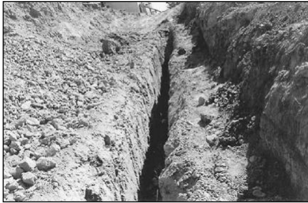
FIGURA 19. ZANJA DE EXPLORACIÓN GEOTÉCNICA (FUENTE: DAY, 2006).
