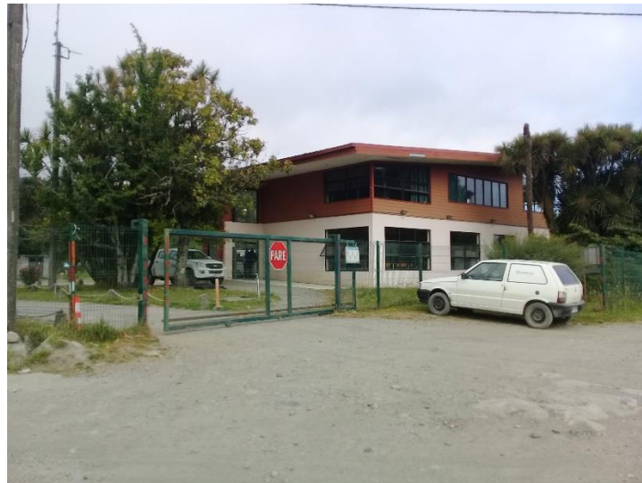
Figura 145: Instalación Centro de Cultivo Rupanco, Salmones Austral, Piedras Negras, 2018.
