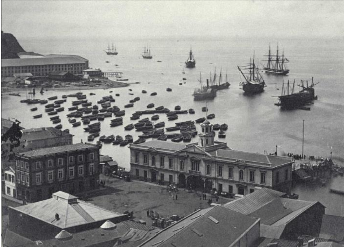
Figura 3-5. Vista del puerto de Valparaíso. Aunque realizada en 1863-64, la fotografía da cuenta de la configuración del puerto en 1855, con los buques de guerra anclados ocupando el espacio al oriente de los Almacenes de la Aduana, en el sector más protegido de la bahía. [Fuente: Sagredo y Puig-Samper 2007: 203]
