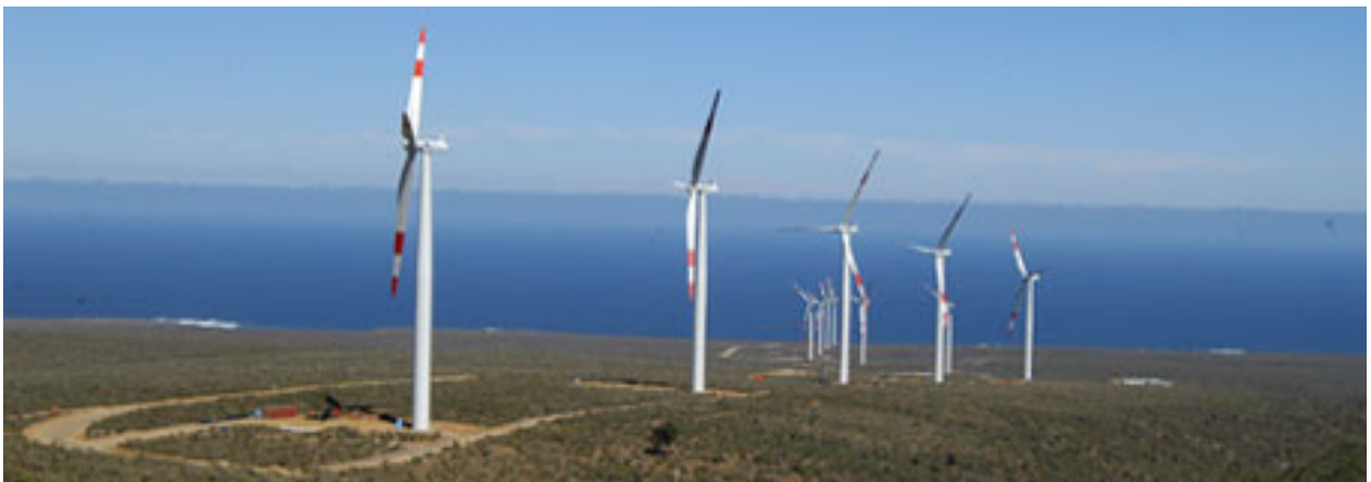
Figura 2.1: Turbinas de eje horizontal en parque eólico Canela, Chile. Fabricante: Vestas.
