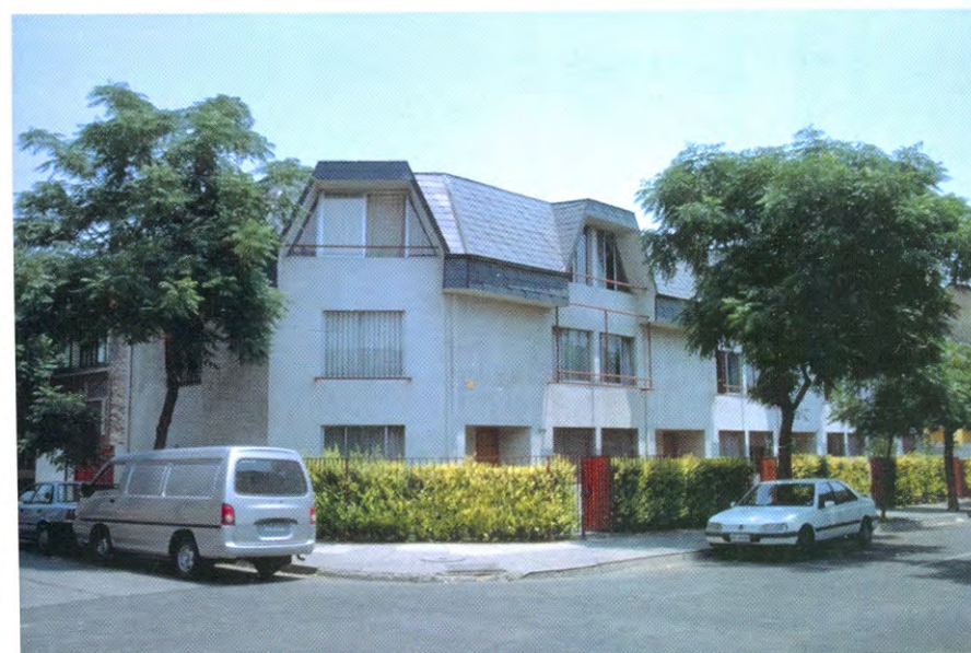
Programa de repoblamiento primera fase (1992). Esquina calle Santo Domingo 2648/06 y Cueto, arq. Jorge Barra. / Plan de repeuplement première phase (1992). Angle des rues Cueto et Santo Domingo 2648/06, arch. Jorge Ibarra.
