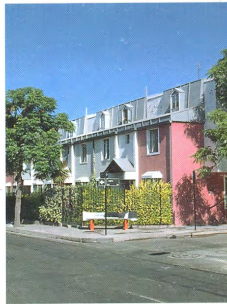
Programa de repoblamiento primera fase (1992). Calle Catedral esquina Bulnes n° 520, arq. Juan Cárdenas Sariego. / Plan de repeuplement première phase (1992). Angle des rues Catedral et Bulnes n° 520, arch. Juan Cárdenas Sariego.
