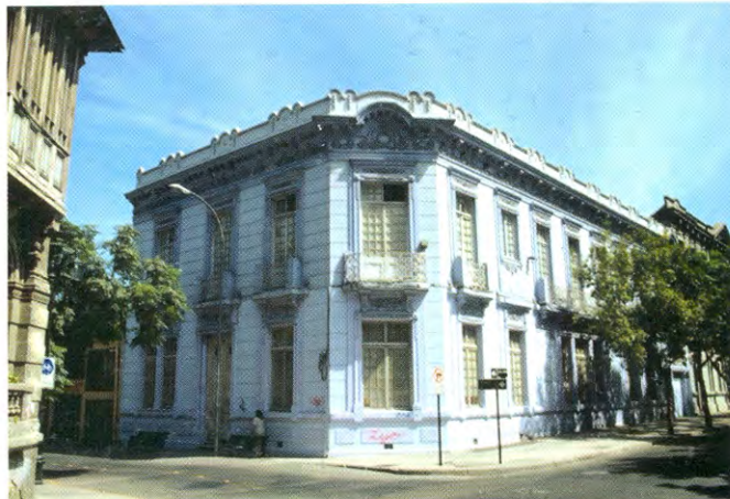
Universidad Arcis, calle Huérfanos y esquina Almirante Barroso. / Université privée Arcis, à l'angle des rues Huérfanos et Almirante Barroso.
