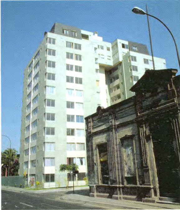
Programa de repoblamiento (1997). Edificio aislado 12 pisos, calle Catedral n° 3033 esquina Maipú, arq. Pedro Iribarne Rios. / Programme de repeuplement (1997). Immeuble de logements de 12 niveaux, à l'angle des rues Maipú et Catedral, n° 3033, arch. Pedro Iribarne Rios.
