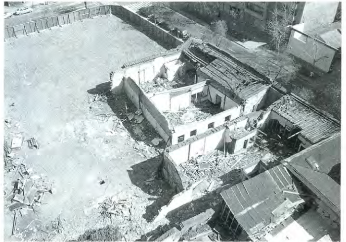
Ejemplo de deterioro del tejido urbano. Manzana comprendida por las calles Grajales, José Miguel Carrera, Almirante Latorre y Gorbea.
