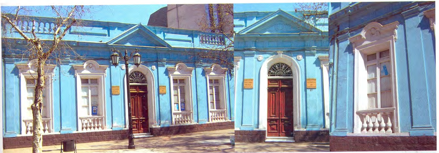
Casa clásica de un piso con dos o tres patios centrados, Av. República n° 41.
