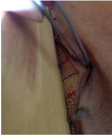
Fig 105. Cinchas de base de una de las sillas.
