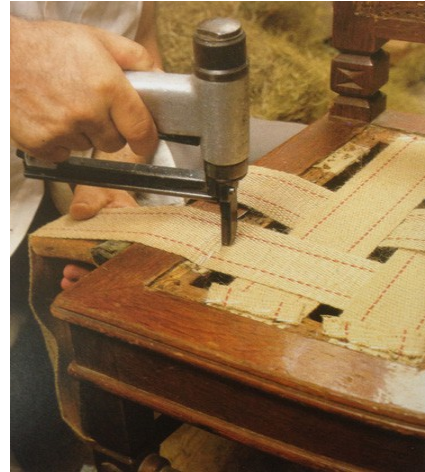
Fig 106. Fabricación de la base de una tapicería.
