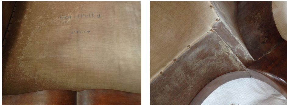
Fig. 48-49. Manchas blancas en textil y madera.
