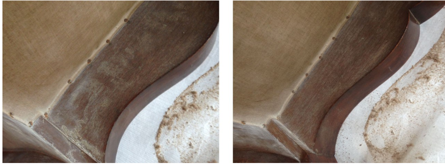
Fig. 55-56. Antes y después de limpieza en seco de manchas blancas.
