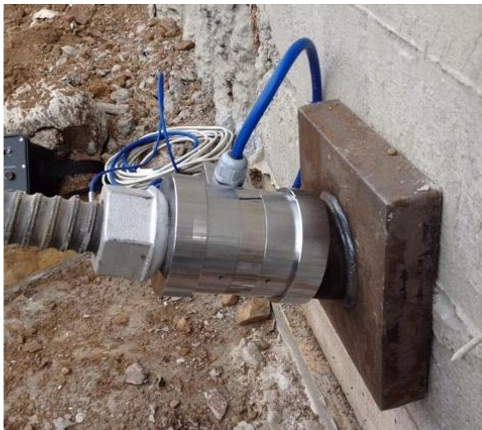
Figura 4.7 Celda de carga de cuerda vibrante
