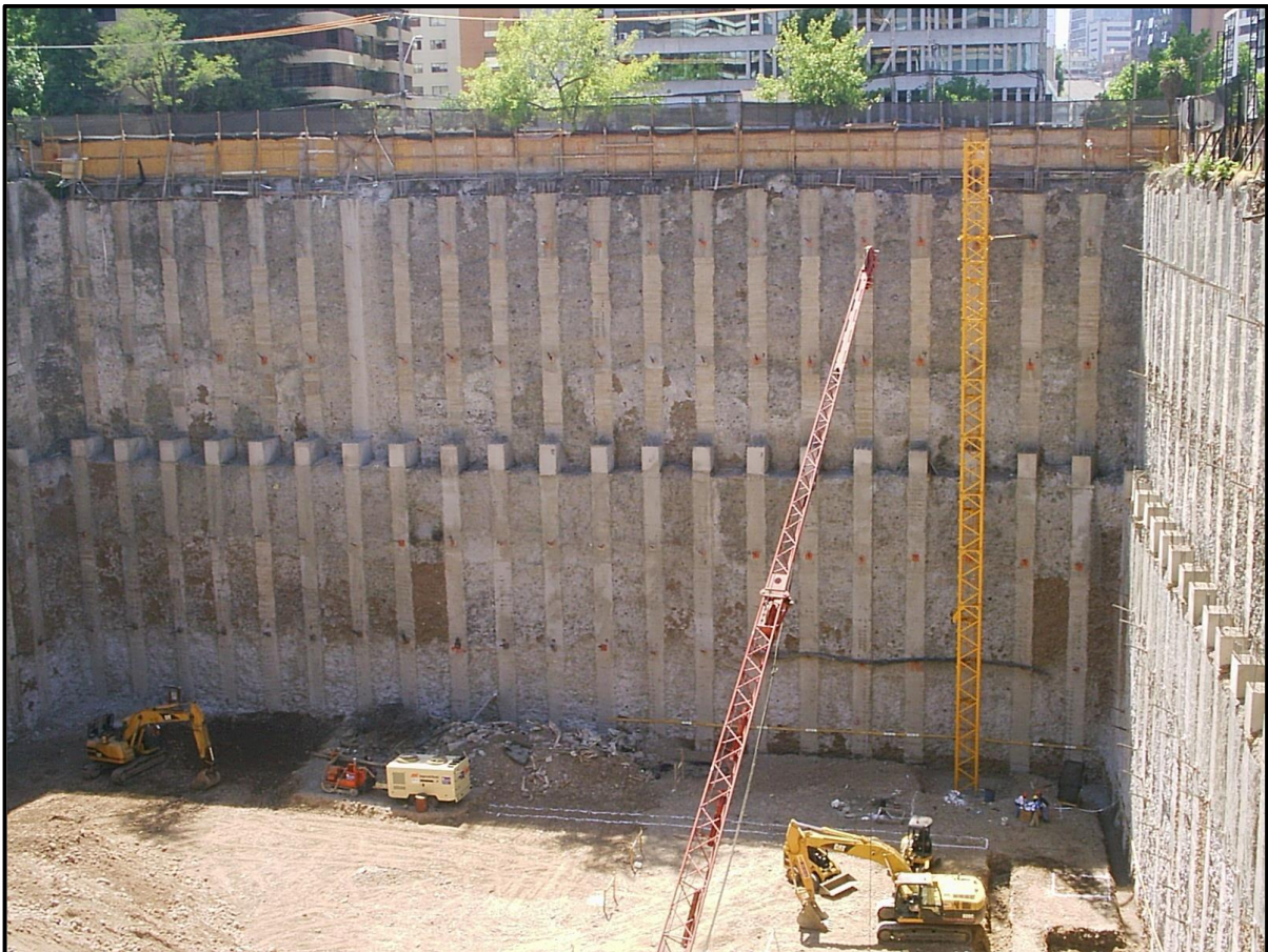
Figura 2.1 Entibación de pilas discontinuas en la grava de Santiago (Saez y Ledesma , 2011) [5]
