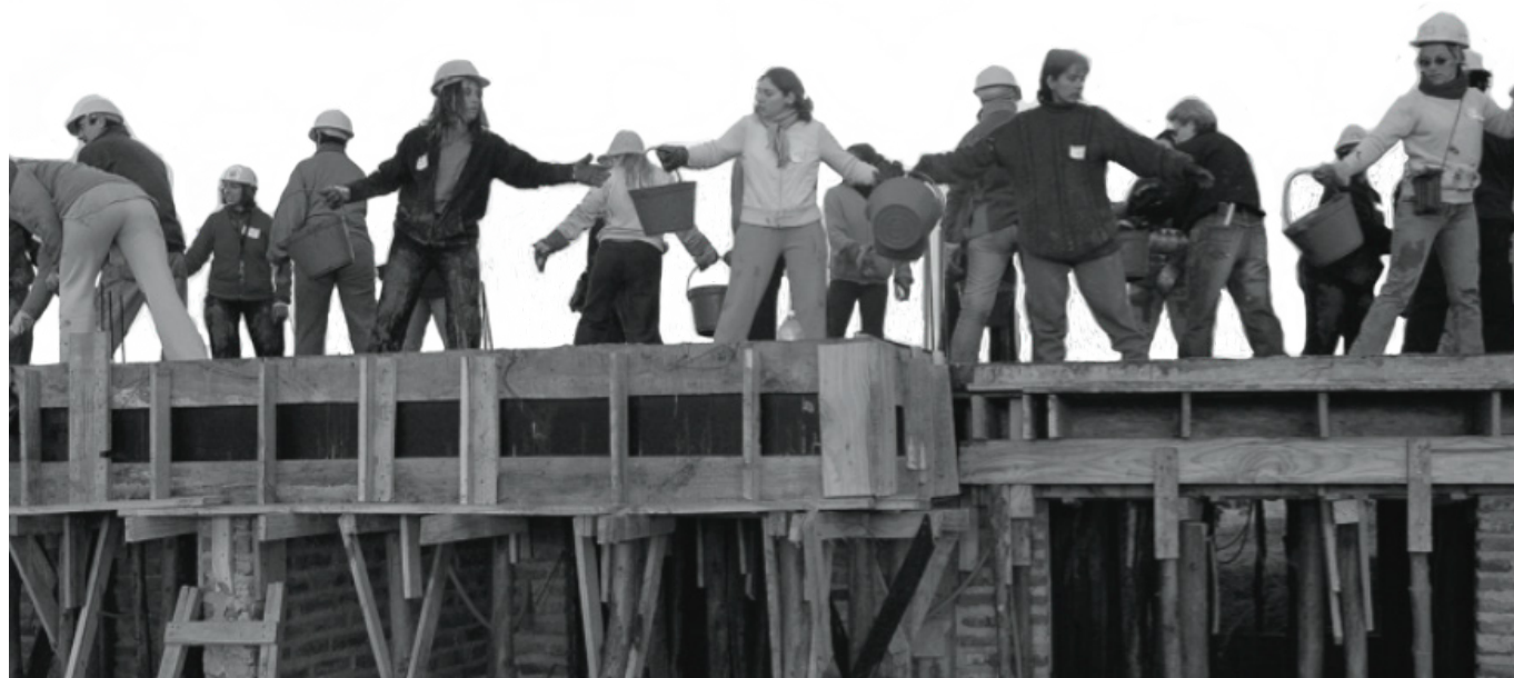
Imagen 17. Unión mediante la autoconstrucción Fuente: https://www.lemiaunoir.com/red-arquitectura-colectiva/
