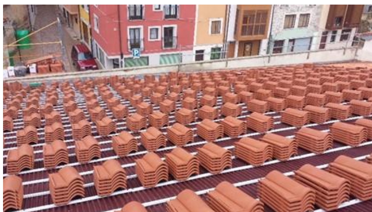
FIGURA 7: INSTALACIÓN TEJAS
