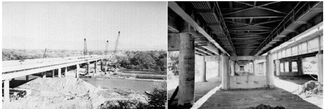
Imagen 2-5: Vista general (izquierda), sección transversal del puente (derecha).
