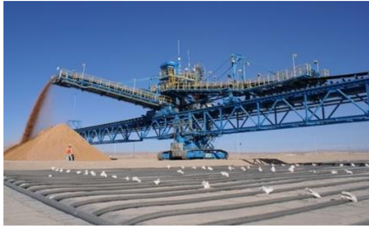
Figura 8: Proyecto OLAP – Minera Escondida
